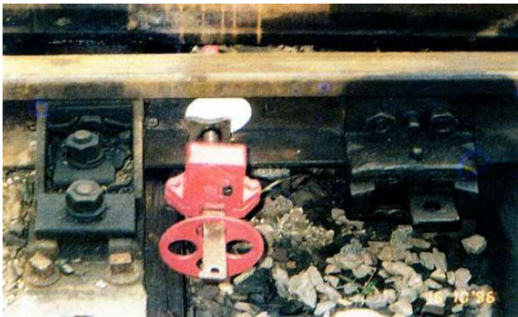
Rys. 5 Iglicę dosuniętą i odsuniętą należy zabezpieczyć wtedy, gdy zamknięcie nastawcze nie działa prawidłowo
